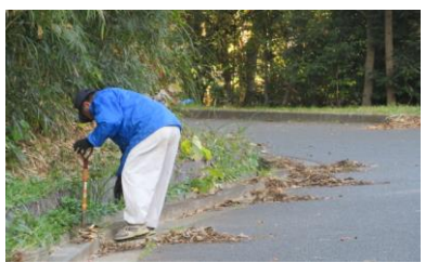
《側溝の泥上げ作業》
