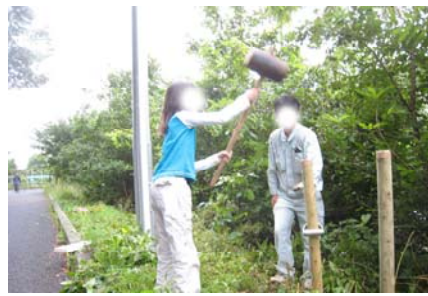
■杭の打ち込み
